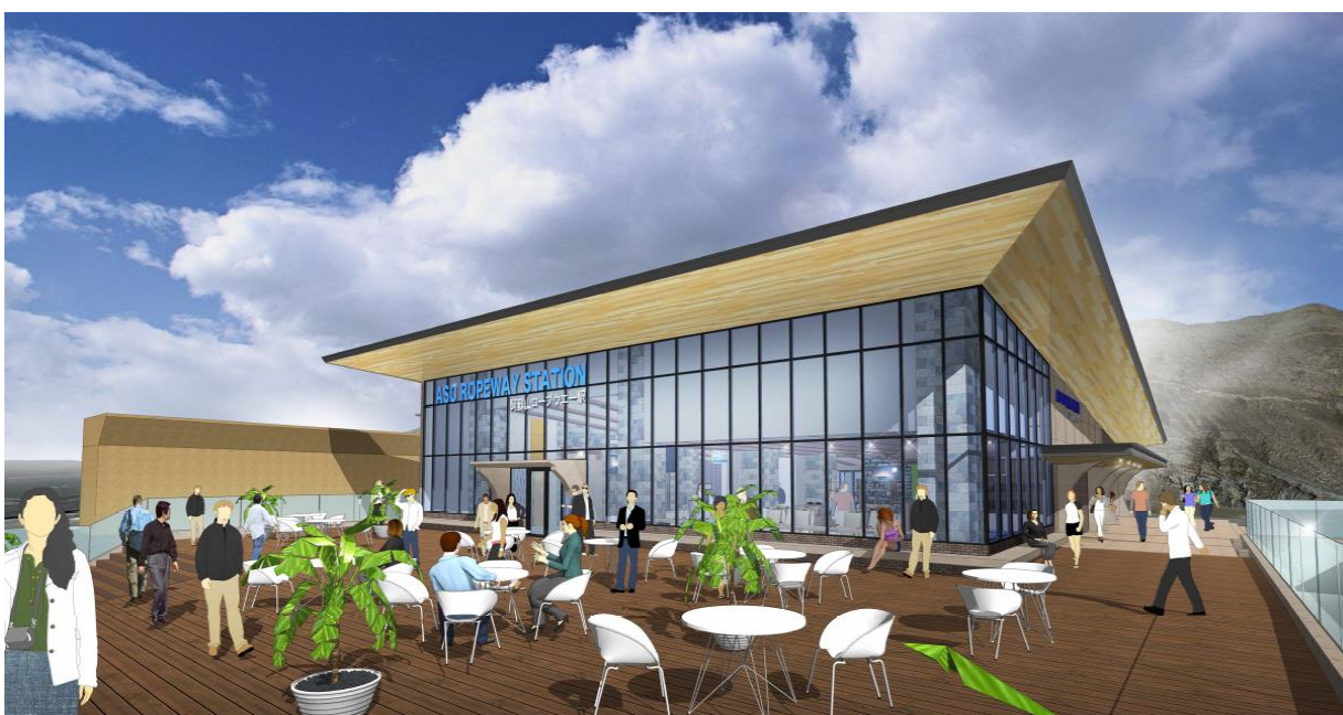
山頂駅（火口西駅）イメージ（RC造2階建て 床面積：1,347.04㎡／建築面積：626.81㎡／高さ：8.6m）
